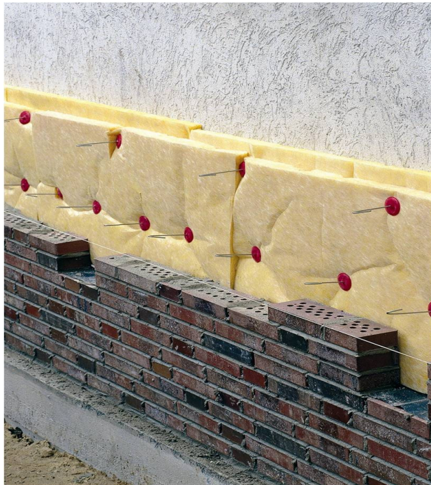
Wärmetechnische Sanierung von einem Gebäude im Bestand
